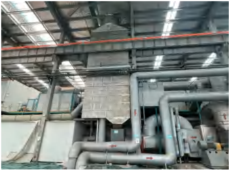
沸石转轮装置+RTO 装置处理
